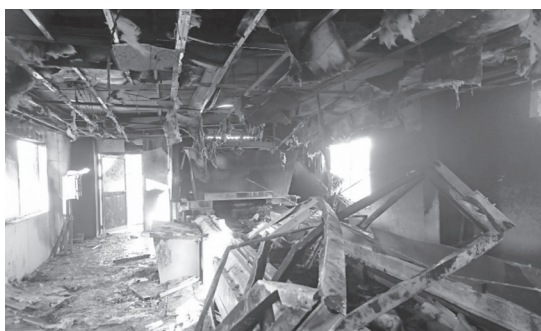
写真3 リチウムイオン電池の発火により、焼けてしまったリサイクル工場
